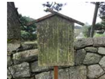
3033 霞ヶ城公園高札型説明板(東 から)板面劣化
