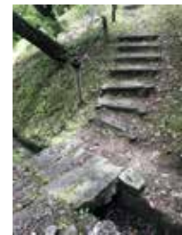
4025 擬木の階段と側溝
