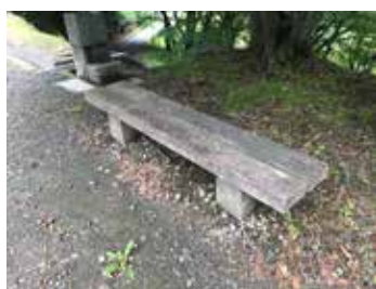
2001 擬木ベンチ 表面汚れ
