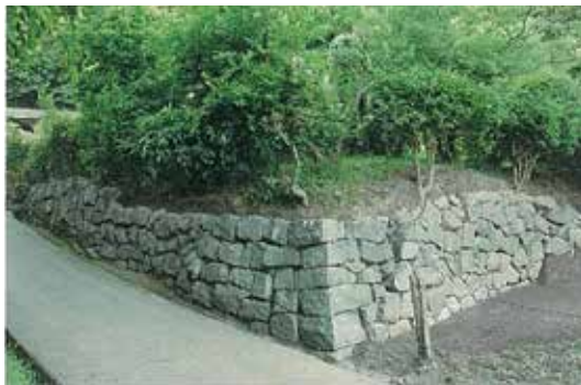
写真120.石垣A・B隅角部(南西から)
