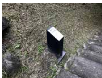
2005 (175) 誘導板 傾斜地設置のため土台下の土が一部 流出している。
