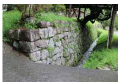
三ノ丸地区 本町谷との境にある二合田用水と石垣（西から）
