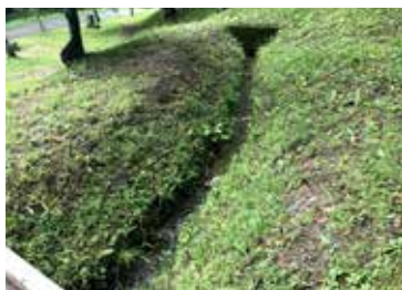
2030 二合田用水 土側溝。
