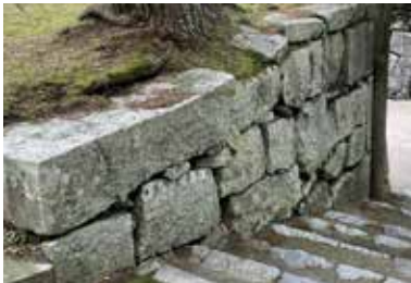
3055 アカマツ北側から三ノ丸東平場への連絡階段東側の石垣の損傷
