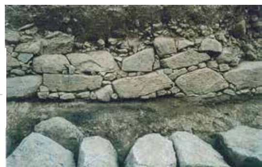
写真 32. 本丸石垣内部で確認された旧石垣
