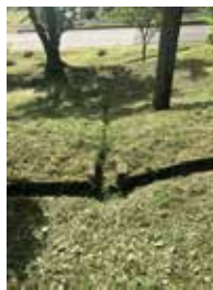
2071 平場からの排水路 分岐箇所のみ養生し、斜面は土側溝。
