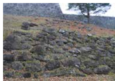
二ノ丸地区 二段石垣 （南から）
