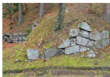
二ノ丸地区 城内路搦手門の 東石垣（西から）
