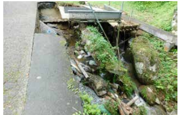
写真 144. 被災の状況(左: R4福島県沖地震時の被災、右: R4集中豪雨時の被災)
