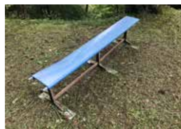
2093・2094 ベンチ 座面の劣化と変形
