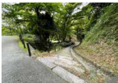
本町谷地区 管理用通路からの降り口（北から）
