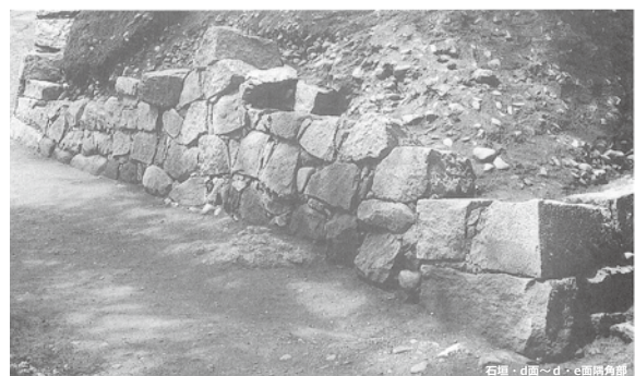
写真 39. 石垣 d 面～d・e 面隅角部
