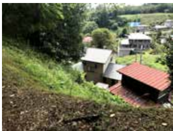
4023 本宮館跡南西面の急傾斜地
