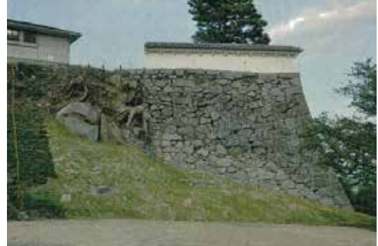
写真 97. 整備終了後全景(南西から)
