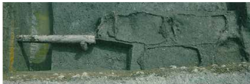
図版 11 2T機木および木質部精査状況(北東より)
