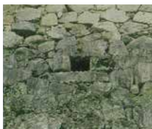
写真 87. 三ノ丸高石垣吐水口
