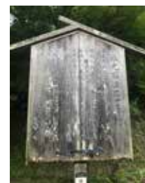
3006 本丸石垣案内 (板面が劣化)
