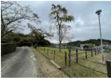
3022 三ノ丸下段東側の侵入防止 ロープ・転落防止柵、車止め(西から)
