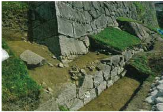
写真 94. 腰巻石垣精査状況
