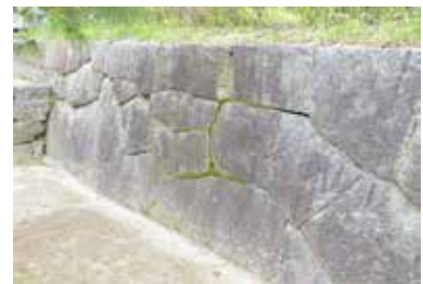
大手門地区 西側石垣（北東から）
