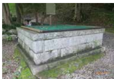
二ノ丸地区 日陰の井戸 （南から）
