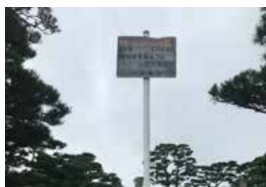
3038 ゴミ持ち帰り注意看板（北から）盤面日焼け
