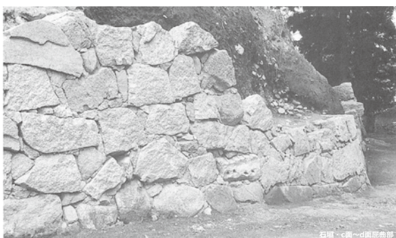
写真 38. 石垣 c 面～d 面屈曲部
