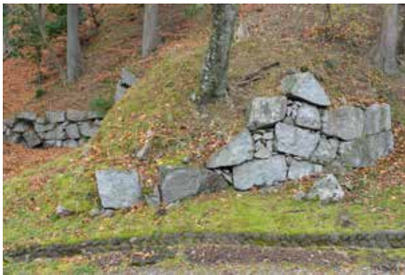
写真 48. 搦手門台東石垣西面
