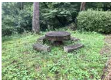
2023・2024 コンクリート製 ベンチ・テーブルは汚れが顕著。 座面が低く草に覆われやすい。
