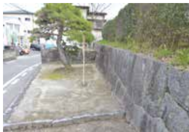
大手門地区 西側植栽（北から）
