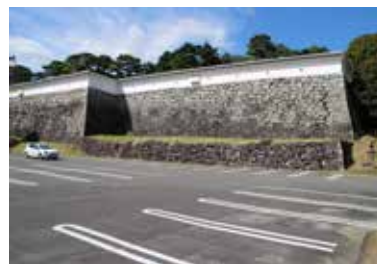
三ノ丸地区 箕輪門東側石垣 (南東から)
